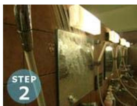
STEP 2 ■②汚れた鏡の表面を十分に水で洗い流してください。 ※過去の洗浄剤等が残っていると白濁の原因になります。
